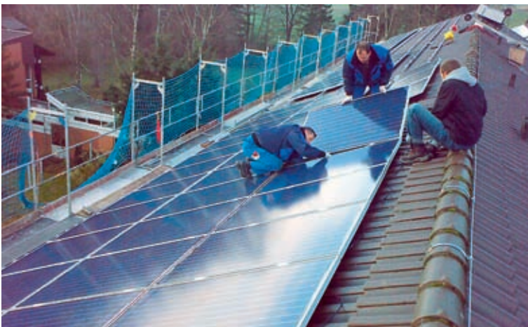
Installation der PV-Module auf dem Bildungszentrum (© Stiftung Arbeit und Umwelt der IG BCE)
